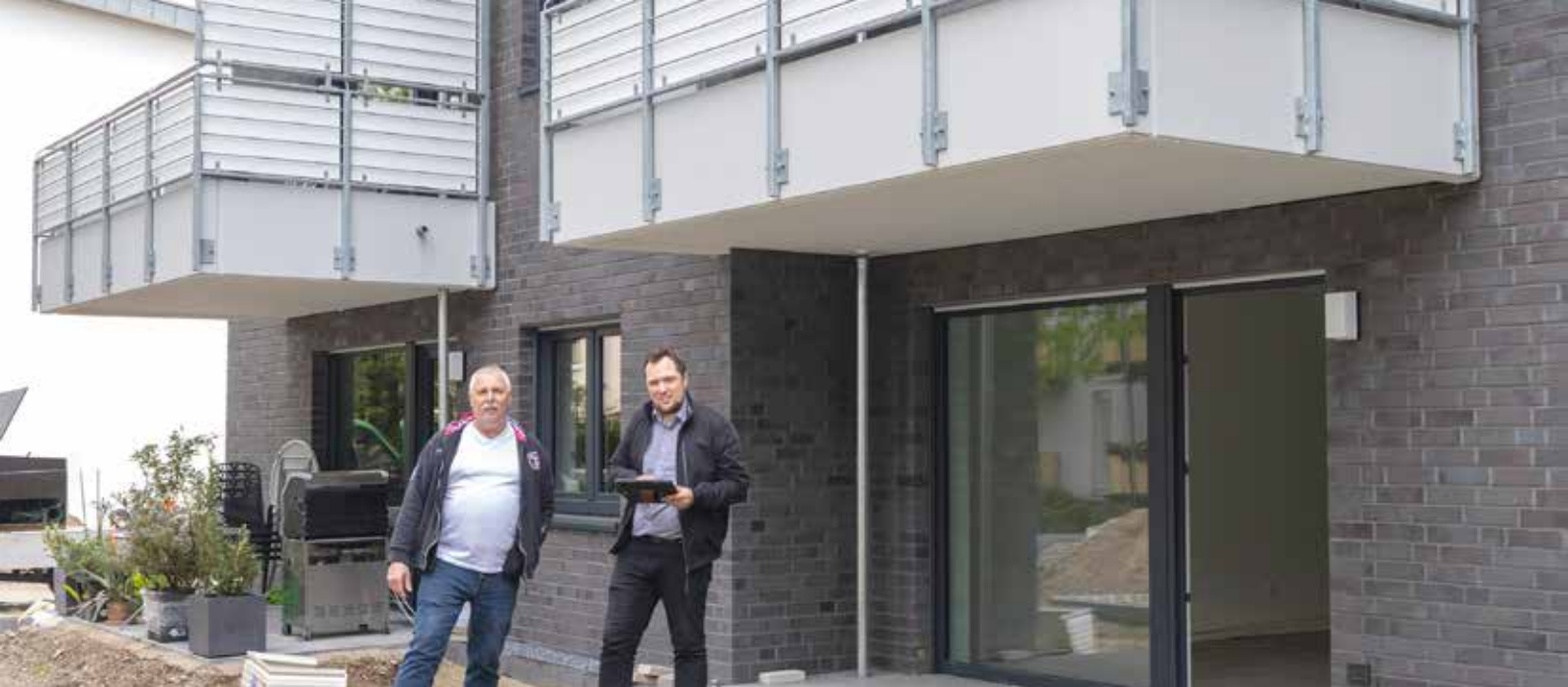
Architekt Lukas Banner (r.) und Bauleiter Jupp Hessing sind zufrieden mit der pünktlichen Fertigstellung.
